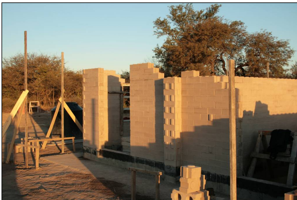
Il cantiere in corso
