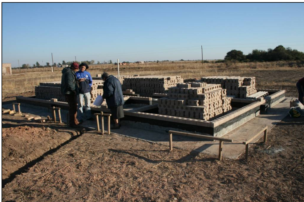
L'avvio del cantiere
