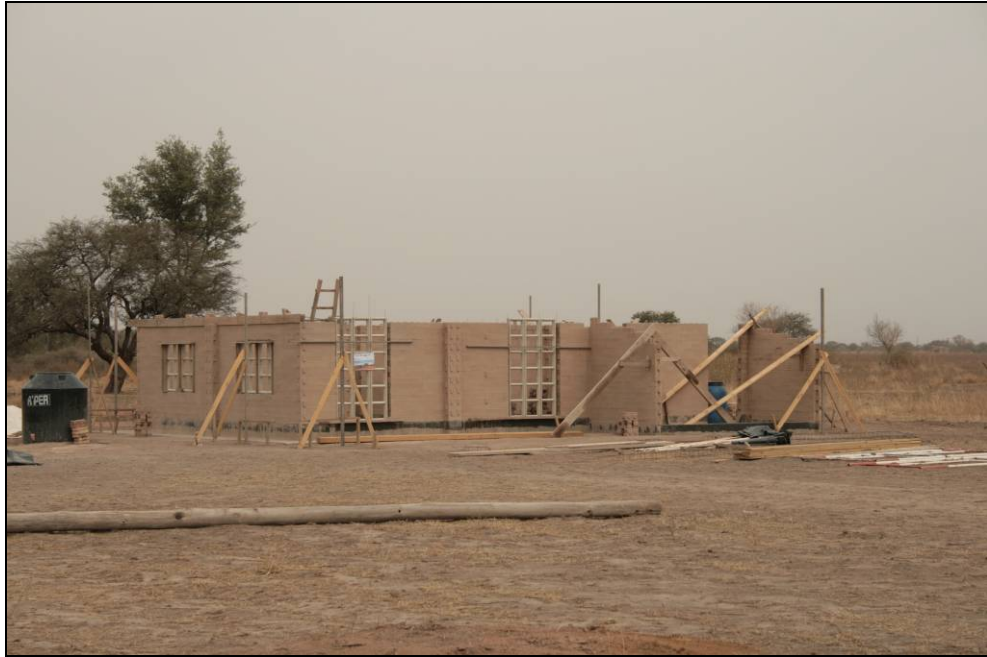
La muratura in fase di completamento
