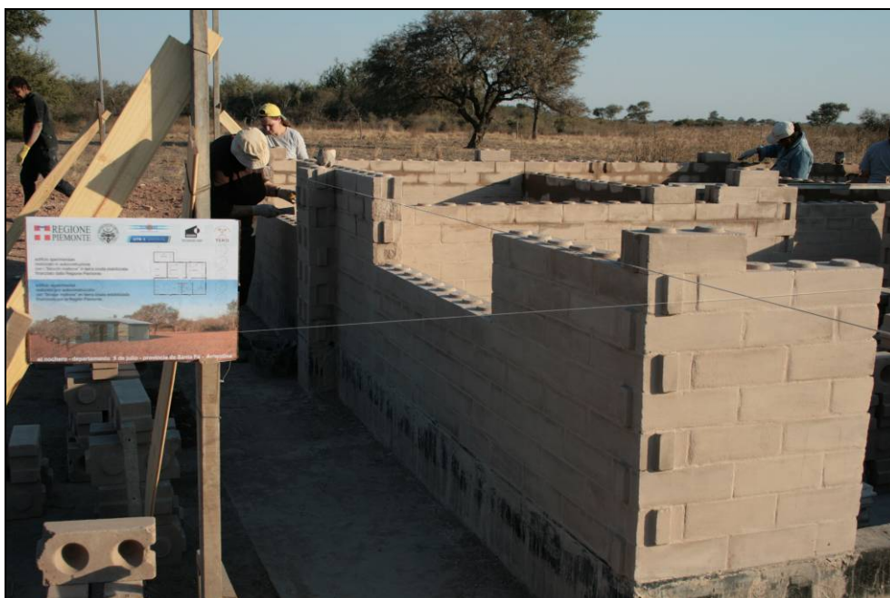
Particolare della muratura
