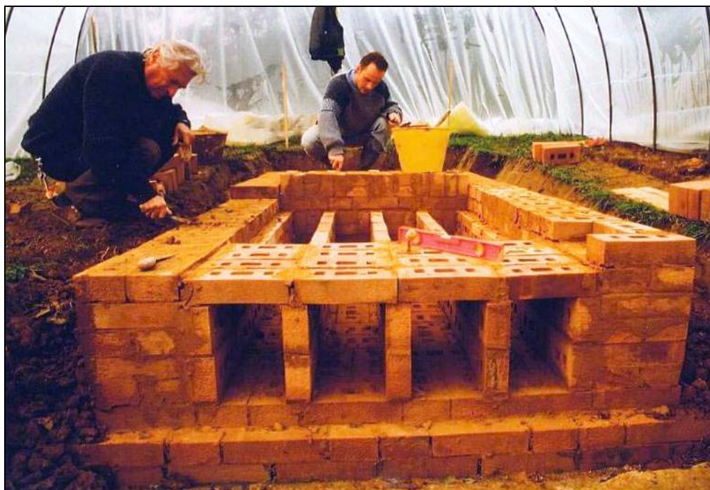
Pralormo (Torino), il forno sperimentale in fase di costruzione
