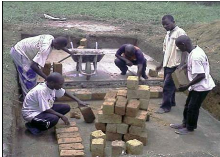
L'avvio del cantiere a N'Kayi
